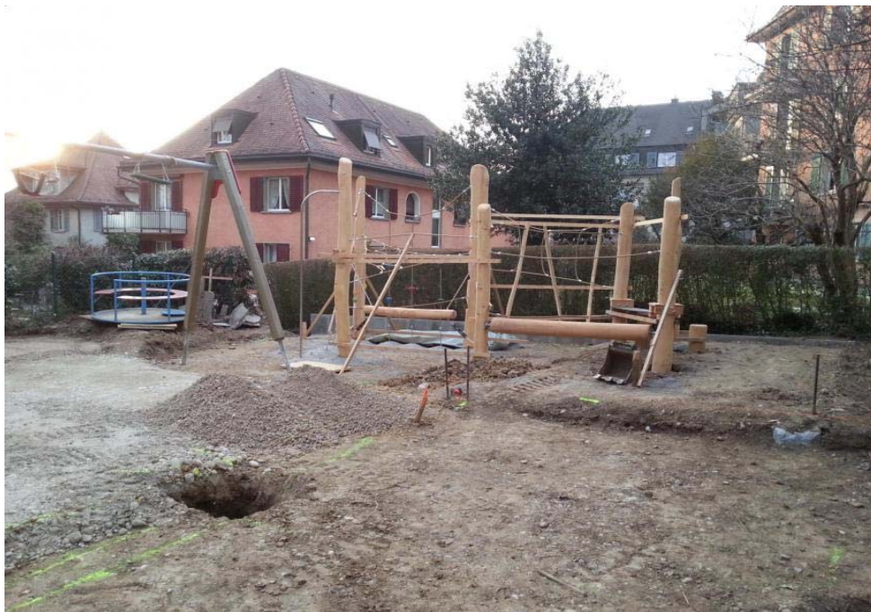
Bildlegende: Der Spielplatz während des Umbaus
